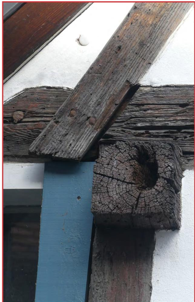
**Fußpunkt des Sparrens, Anschluss an den Deckenbalken mittels Verblattung.**
