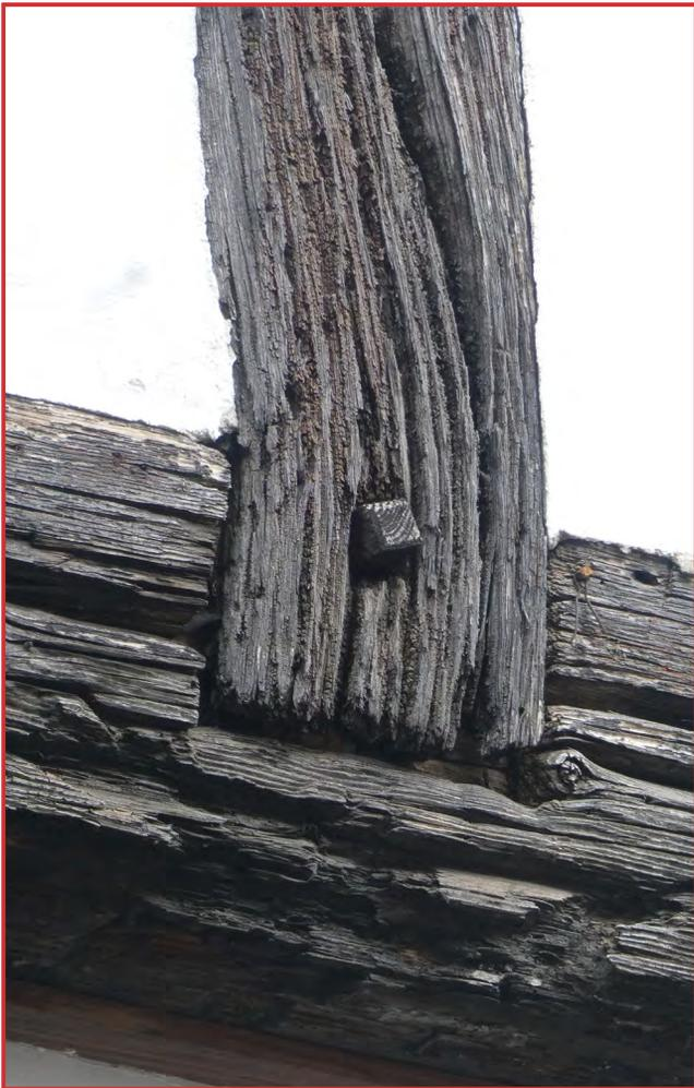
**Detail der sorgfältigen Ausführung eines Blattes mit dem starken Holznagel.**
