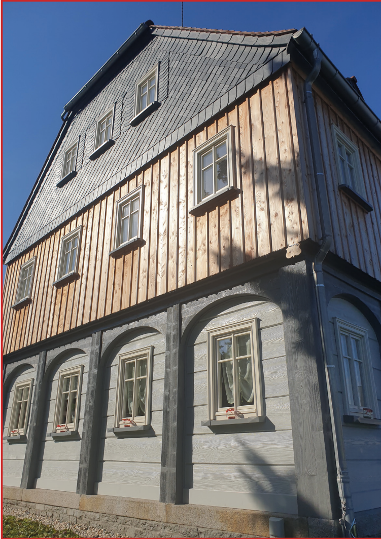
Das Umgebindehaus steht im Zentrum der Tätigkeiten im UmgebendeLandSommer 3 .
