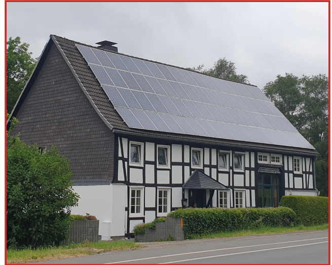
Beispiele zeigen, dass Photovoltaik auch auf Fachwerkgebäuden zum Einsatz kommen kann. Foto: Laura Plugge
