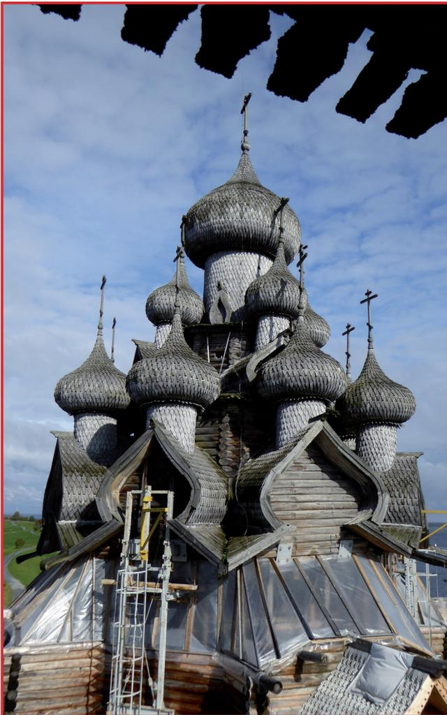
Zwischen dem Unterteil und dem Oberteil der Kirche auf Stahlstützen sind 3,5 m der Höhe nur mit Folie geschlossen.
