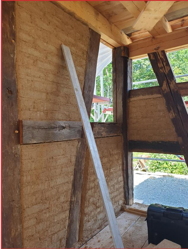
**Das zum Teil bereits ausgefachte Erdgeschoss des Musterhauses mit Lehmmauerwerk. Alle Fotos: Laura Plugge**
